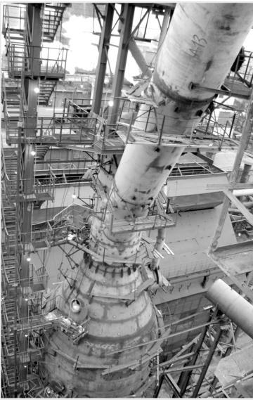
БЗУ (ведутся наладочные работы), атмосферные клапана, консольно-поворотный кран на площадке, отметкой которой 70 метров 800 миллиметров
